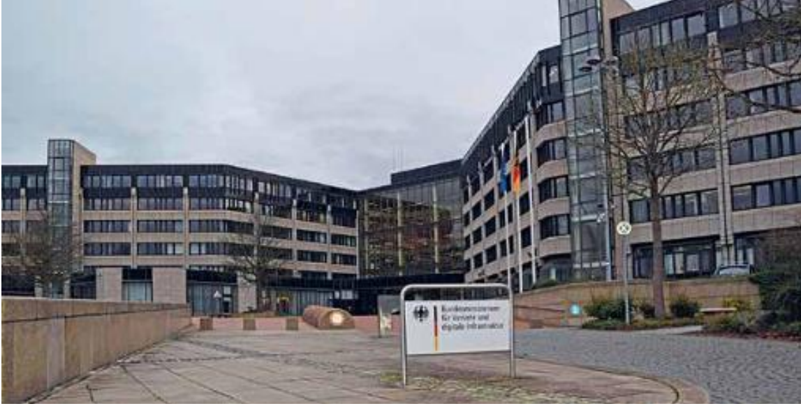
Im Gebäude des Bundesministeriums für Verkehr und digitale Infrastruktur in Bonn sind sechs Gebäudeflügel mit jeweils sechs Stockwerken zu reinigen.
